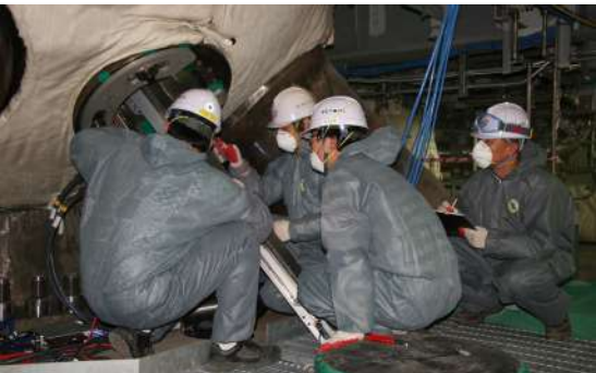
Testare Curentă Eddy pentru Tuburile SG
