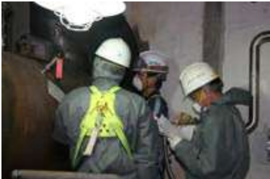
NDT Konvensional & Canggih untuk Perpipa, Komponen dan Struktur
