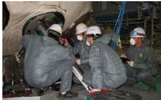
اختبار التيار الدوامي لأنابيب مولد البخار
