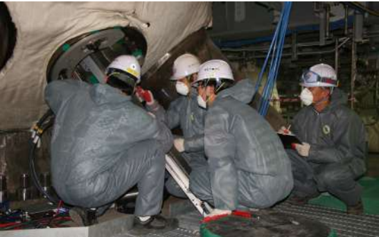
Kiểm tra dòng điện xoay cho ống SG
